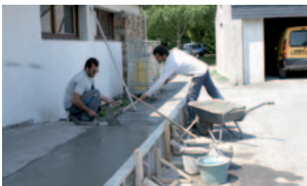
Travaux d'élargissement du quai
